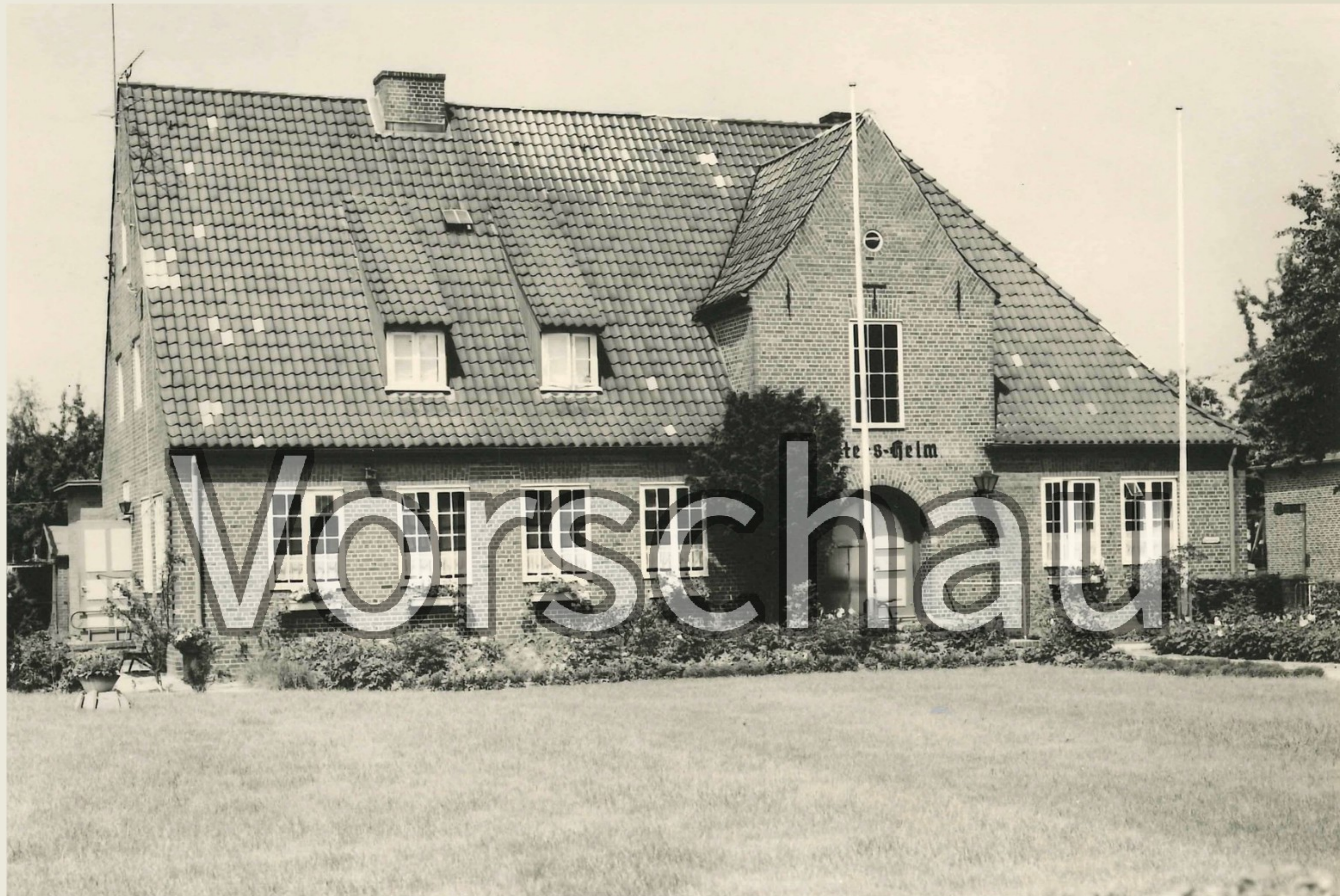
Altenheim der Gemeinde Lägerdorf in der Dorfstraße, jetzt Feuerwache
